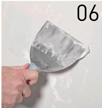
Aplicar una capa de **TKROM IMPRIMACIÓN FIJADORA F1** sobre las zonas saneadas y sobre las superficies que por la humedad no presenten buena dureza superficial.
